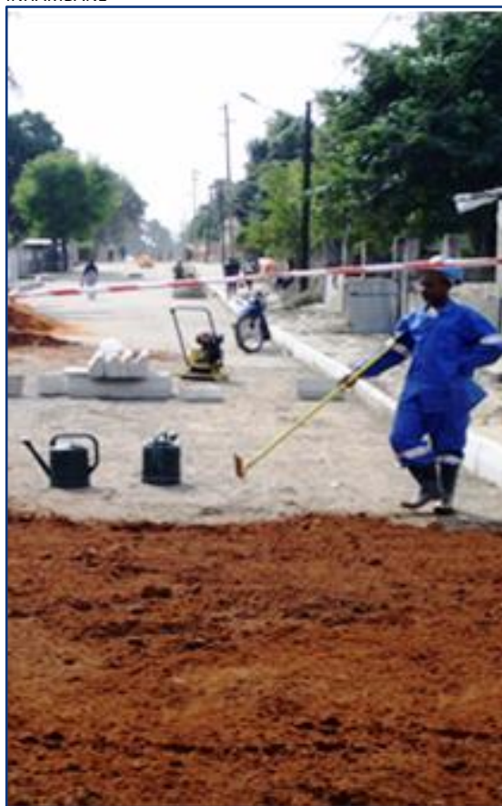
CONSELHO MUNICIPAL DA CIDADE DE INHAMBANE - REABILITAÇÃO DE ESTRADAS URBANAS NA CIDADE DE INHAMBANE
