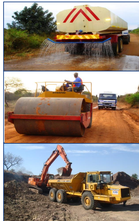
GOVERNO DA PROVÍNCIA DE MAPUTO - OBRAS DE MANUTENÇÃO DE ESTRADAS TERRAPLANADAS
